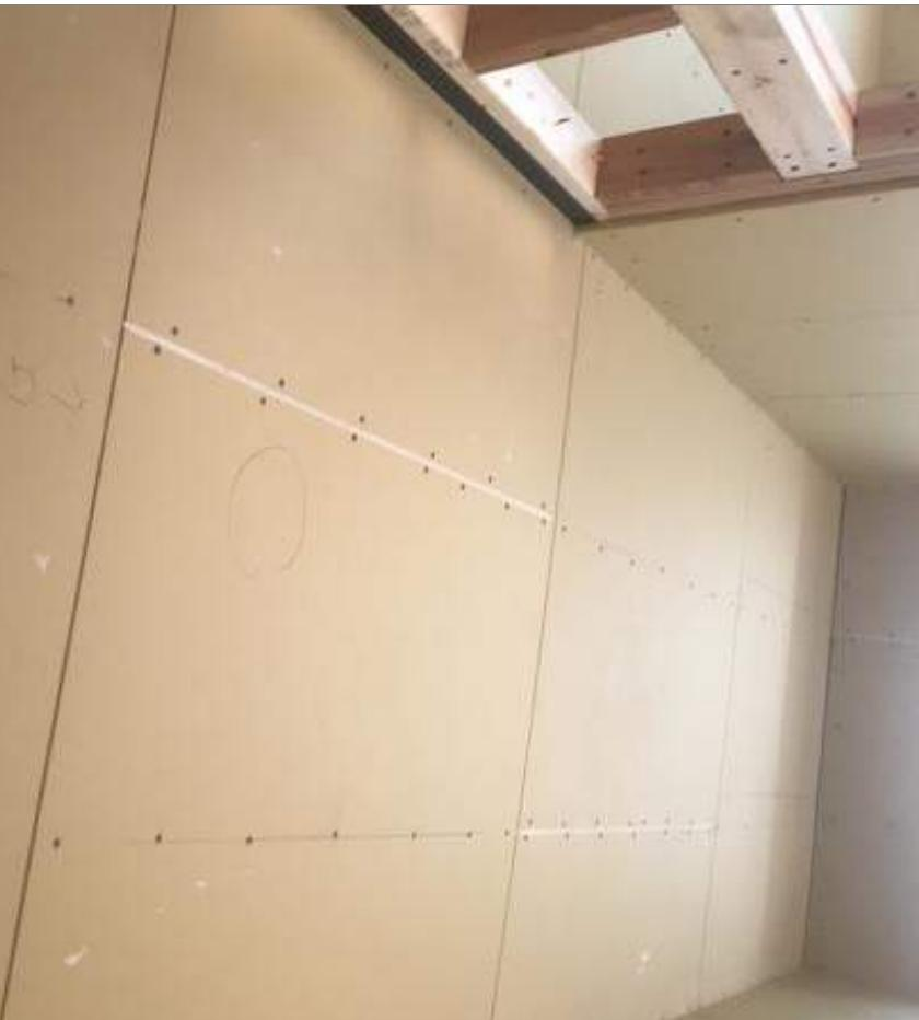
1-15 くぎ打ち間隔は外周100mm以内、中間部200mm以内の間隔で留め付ける。 (2枚張りの場合) くぎ打ち間隔は外周部及び中間部とも200mm以内とする。
