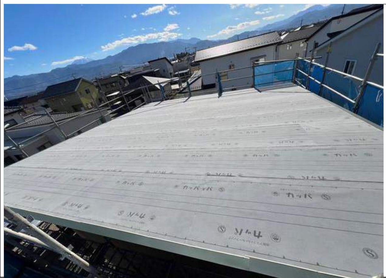
1-23 屋根ルーフィングの立ち上がり250mm以上確保し、上端は気密テープで圧着する。かつ雨押さえ上端より50mm以上とする
