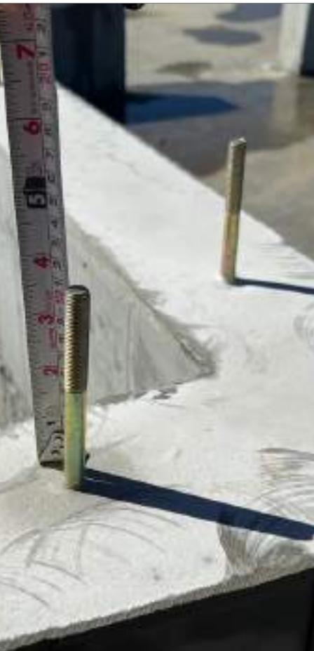
1-13□接合金物の種類・施工位置が図面通りか確認する。
